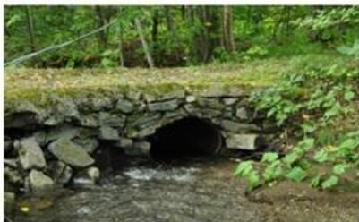
Passerelle et ponceau en arche permettent de réduire l'impact sur le lit du cours d'eau
